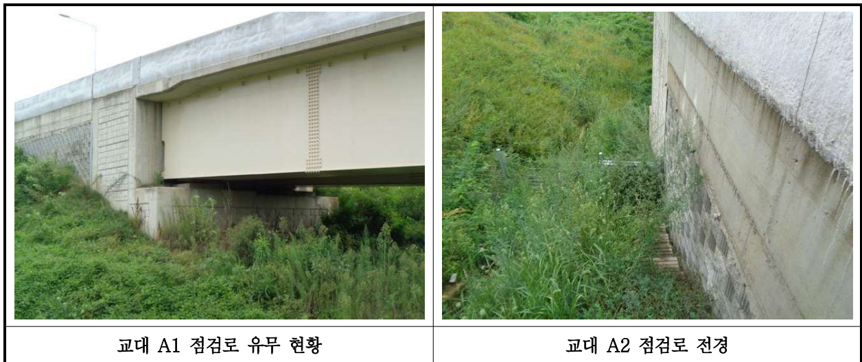
【사진 21.3.23】 교량 점검시설 전경
