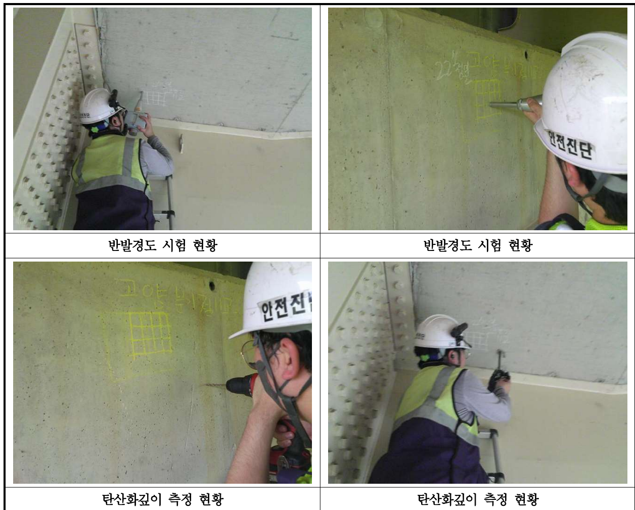
【사진 21.4.1】 콘크리트 내구성조사 현황
