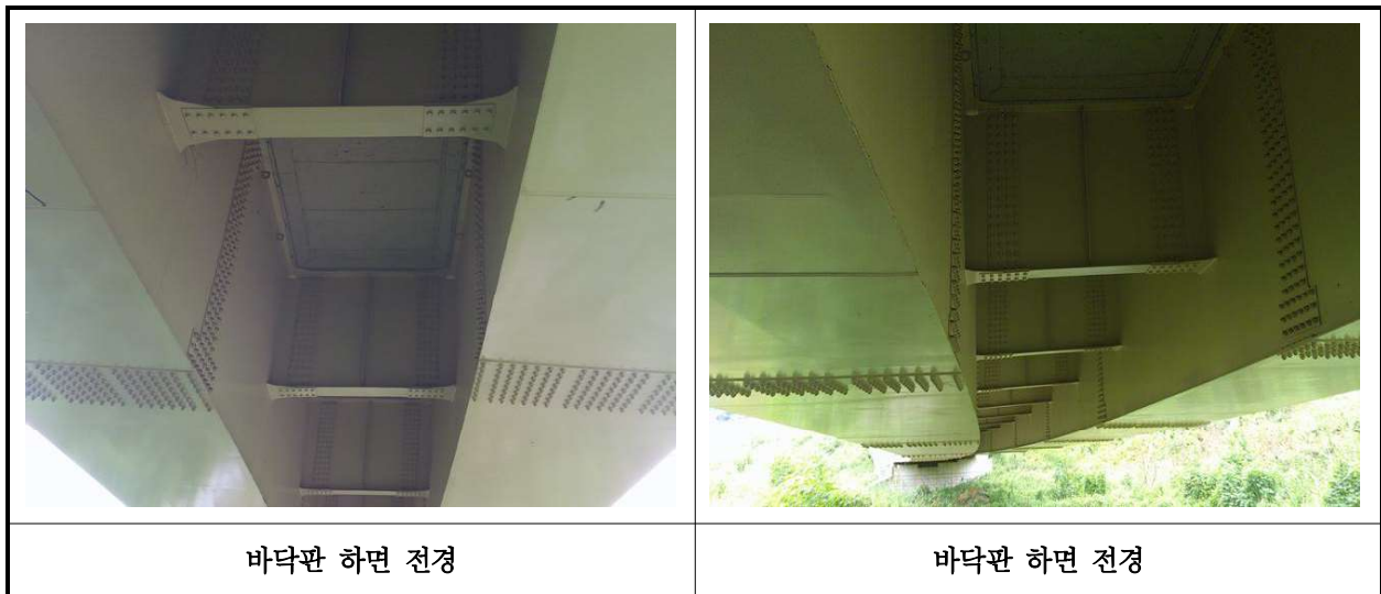
【사진 21.3.2】 바닥판하면 전경
