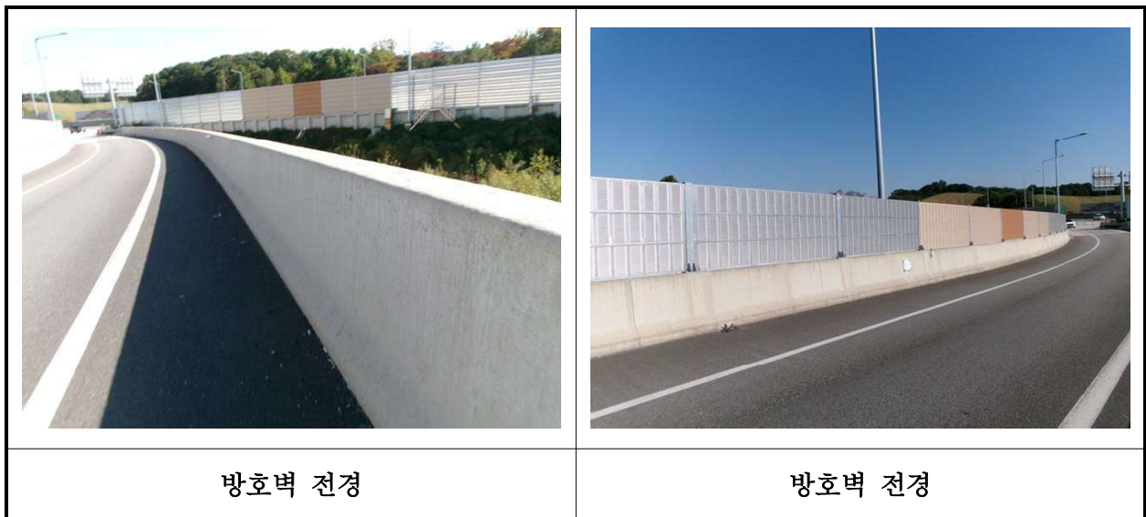
【사진 21.3.21】 방호벽 및 중앙분리대 전경
