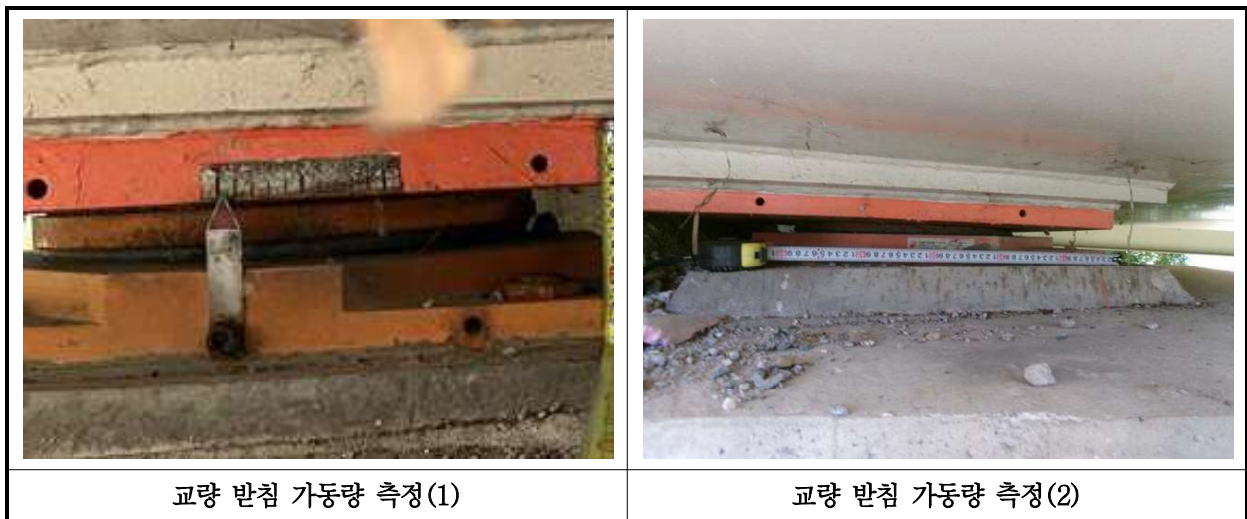
【사진 21.3.13】 교량받침 이동량 측정
