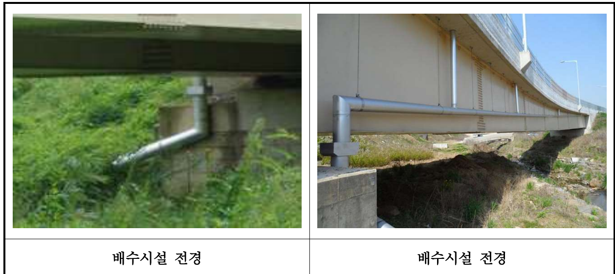
【사진 21.3.19】 배수시설 전경
