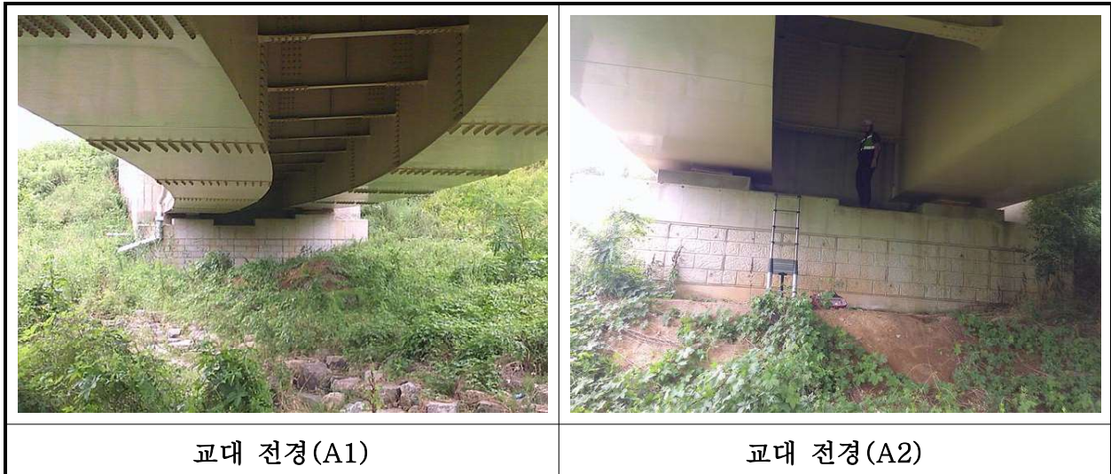
【사진 21.3.8】 교대 전경
