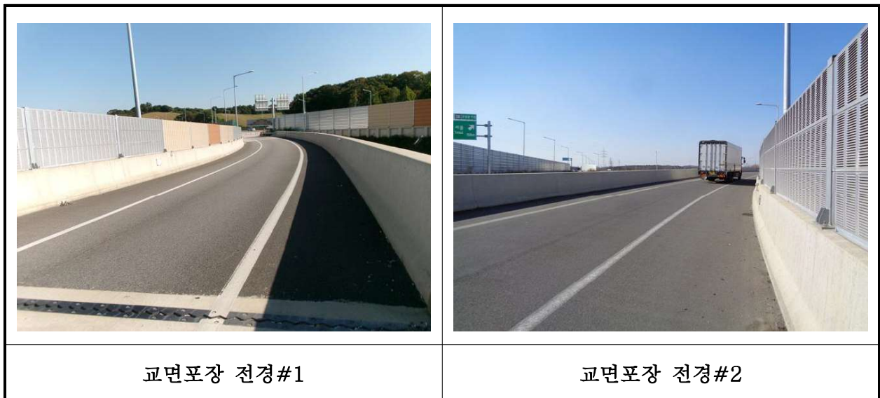
【사진 21.3.17】 교면포장 전경
