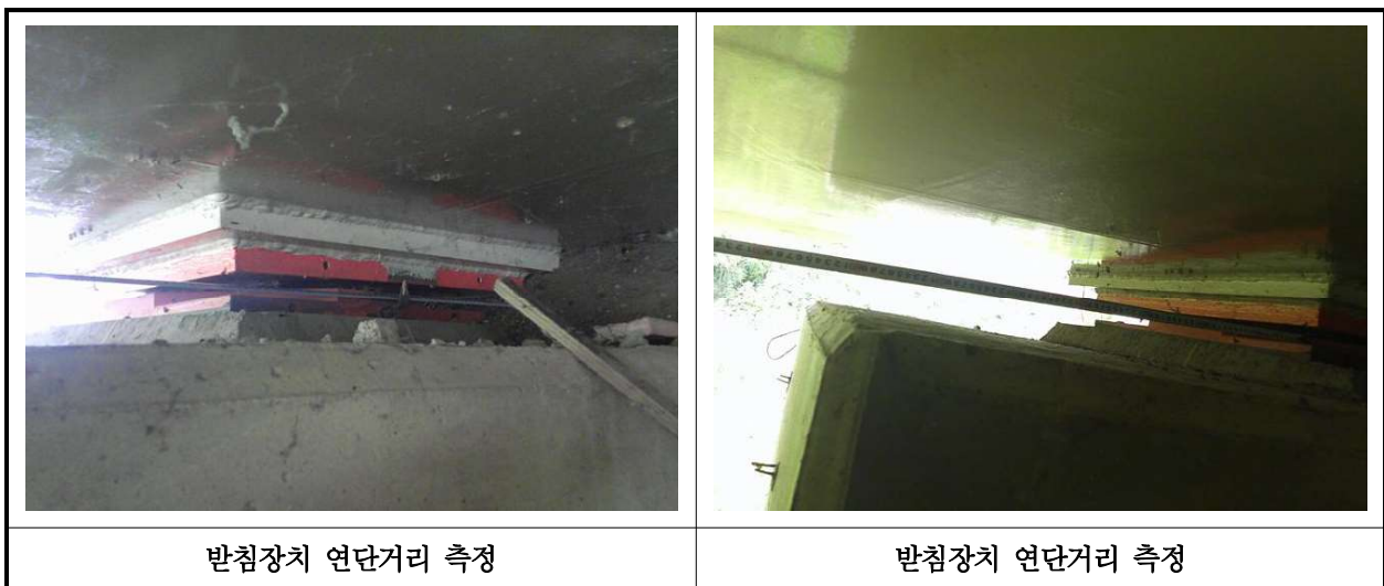
【사진 21.3.12】 교량받침장치 연단거리측정
